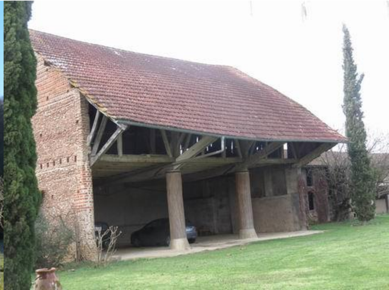
St Sever de Rustan
